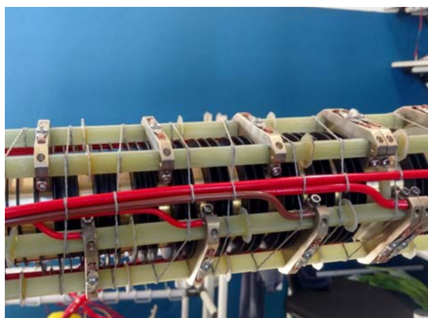
Montagem dos fios e amarração (Figura 4)
