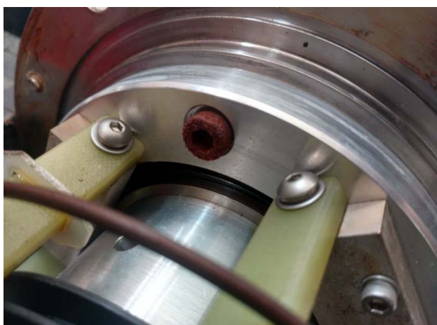
Sinais internos de umidade (Figura 5)
