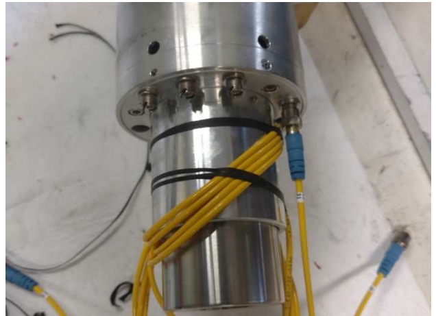
Entrada - Conexões integras da porção óptica
