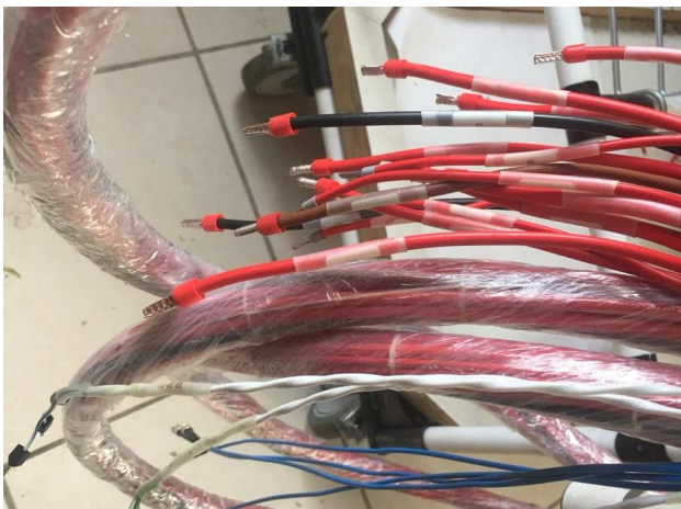
Identificação dos fios e substituição de seus terminais agulha
